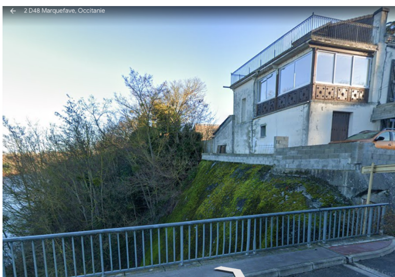
Capture d'écran Google Earth du bâtiment construit sur la parcelle C 287
